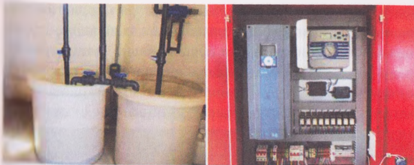
21-расм. Ўзгитловчи мослама ва суғориш тизимни бошқариш учун автомат қурилма
