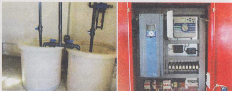
20-расм. Ўғитловчи мослама ва суғориш тизимини бошқариш учун автомат қурилма
