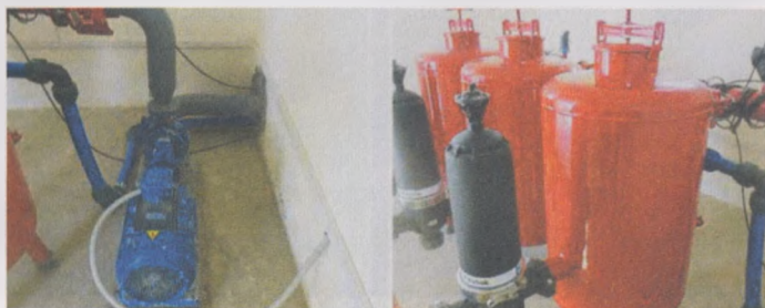
19-расм. Сув насоси ва сув филтрити
