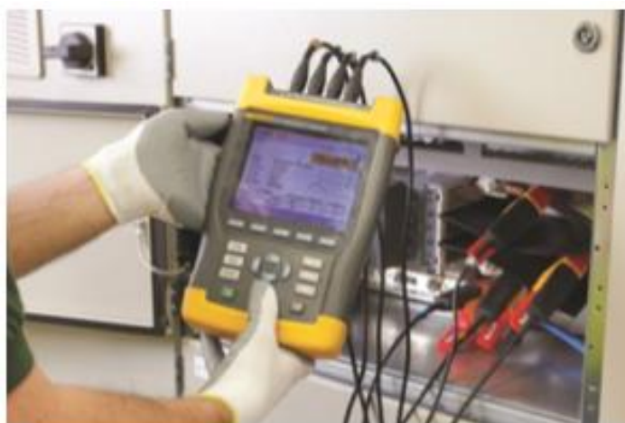
4.5-rasm. Elektr tarmoq parametrlarini tezkor aniqlash jarayoni.
