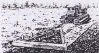
Rasm 8. Ildiz va poyalarni tozalovchi tirkamali borona.
