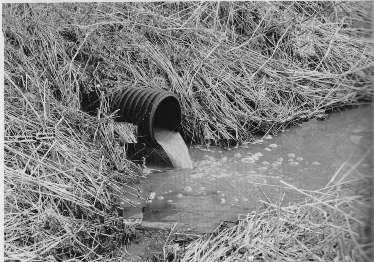
10-расм. Ер ости коллектор дренаж тизими 1
