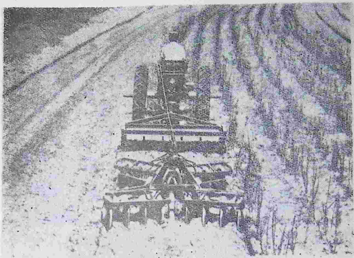
4-расм. Диск боронали барабан типдаги ғўзапоя қирқадиган машина.
