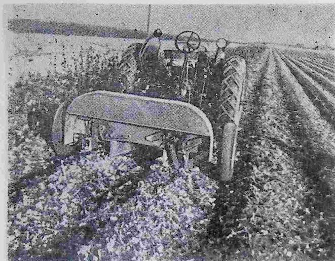
3-расм. Ғўзапояларни майдалайдиган икки қаторли машина.
