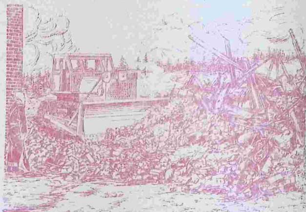
Рис. 75. Устройство проездов в завалах.
