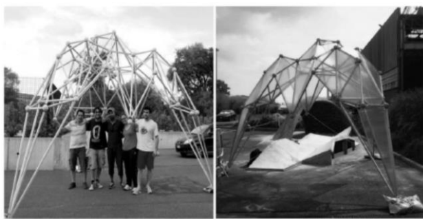
4-расм. Фрактал асосидаги панжара қобикнинг тузилиши (а) панелсиз ва (б) қоплама панеллари билан.
