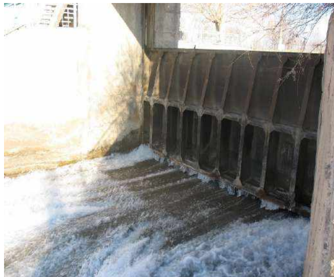
2-расм. Шитларидан сувнинг сизиб ўтиш ҳолати.
