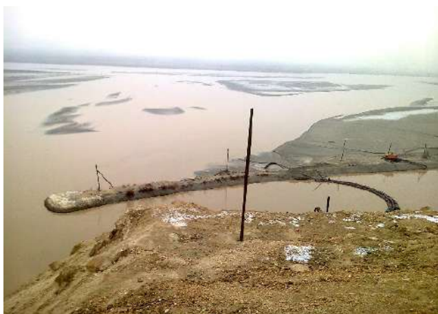
Рис.1. Запань на водозаборе из реки Амударья и НС-1 КМК
