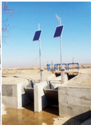
Рис 3. Головной водозабор после реконструкции
