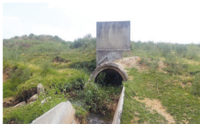
1-расм. Вертикал қувур билан нов канал тизимидаги туташтирувчи иншоот ҳолати
