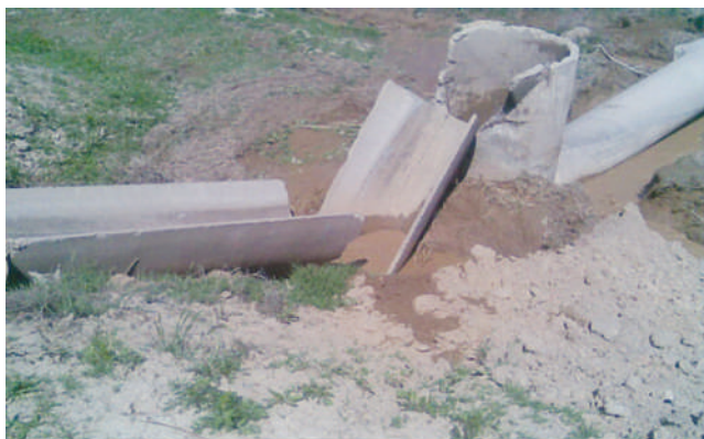
1-расм. Вертикал қувур билан нов канал тизимидаги туташтирувчи иншоот ҳолати
