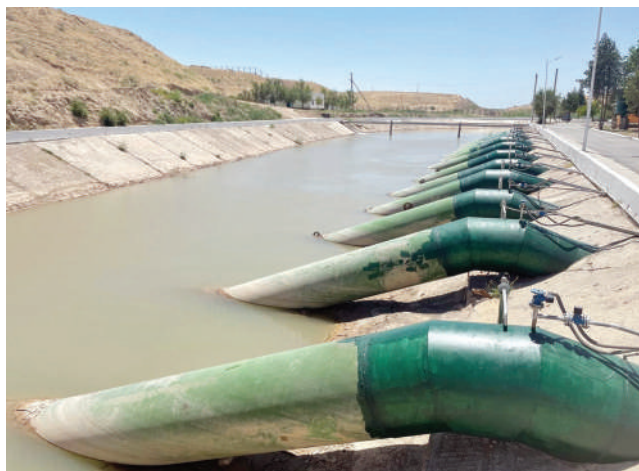
Рис.3– Реконструкция всасывающих трубопроводов и водоприёмника НС «Кизилтепа-1»
