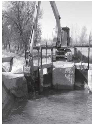
Рис 2. Головной водозабор до реконструкции
