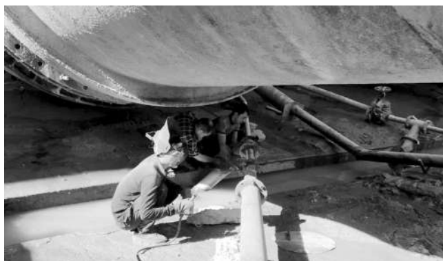
Рис.1 Монтаж струйного насоса
