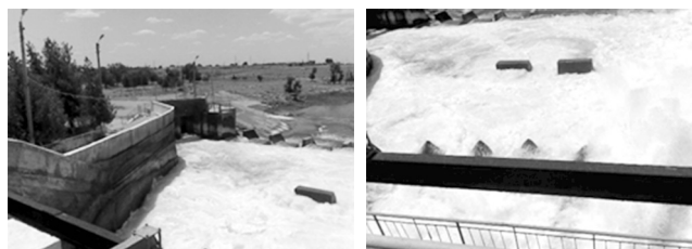
Расм 1.1. а) Чимқўрғон сув омборининг сув чиқариш иншооти пастки бьефининг ҳозирги ҳолати.
