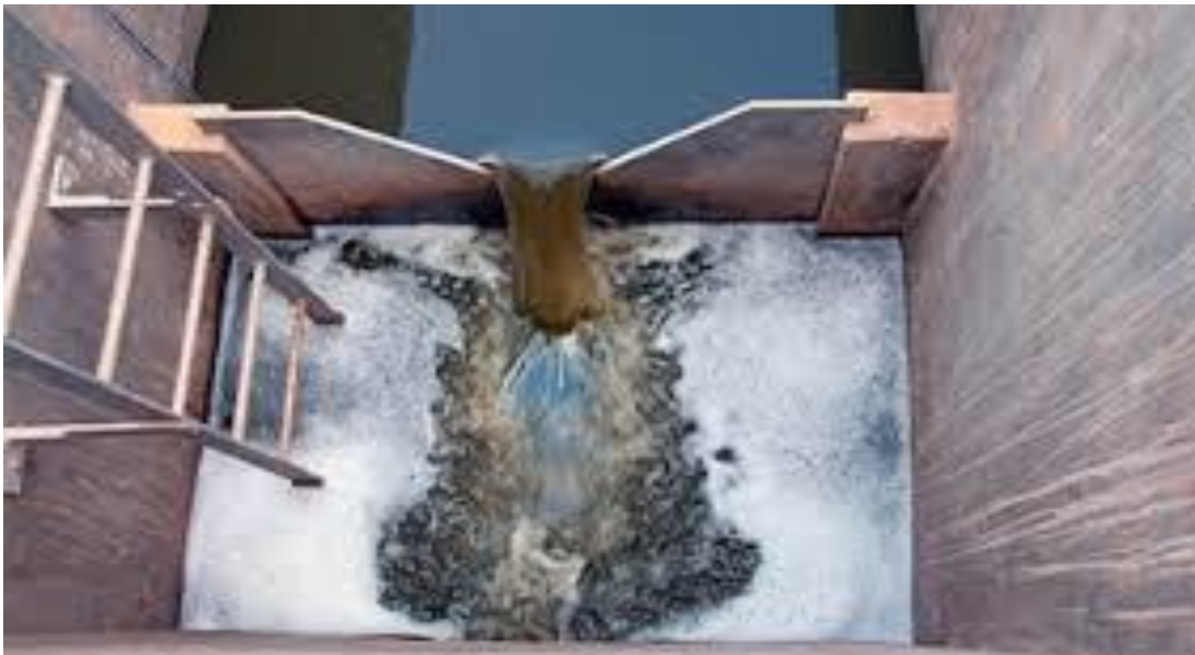
1-расм. Саноат оқова сувларини қабул қилиш қудуғининг умумий кўриниши
