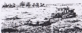
Rasm 11. Katta toshlarni zanjir bilan chiqarish
