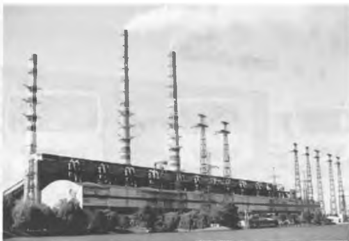
Рис.13. Сырдарьинская ТЭС вырабатывает до 3000 МВт энергии.
