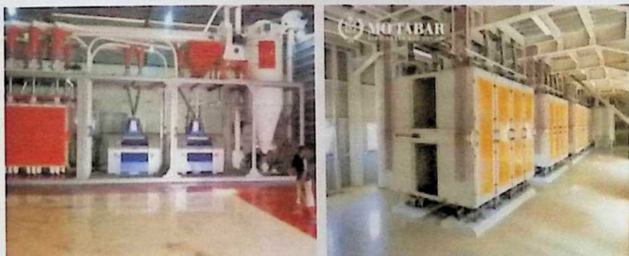
Zamonoviy Mo'tabar un tegirmonining ichki ko'rinishlari (Toshkent)
