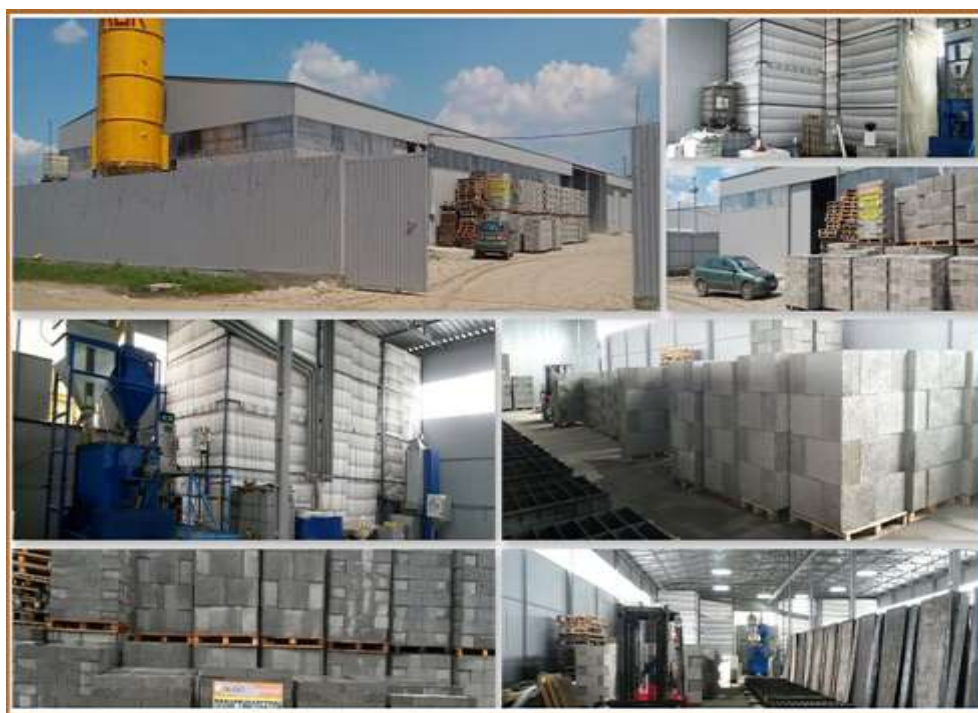
7.6-rasm. Polistirolli beton bloklari ishlab chiqariladigan zavod.
