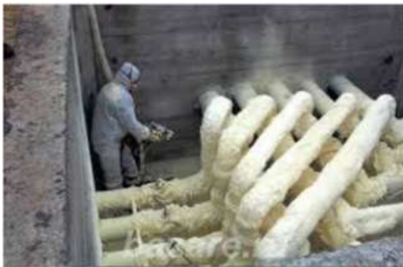
13.4-rasm. Issiqlik izolyatsiyalovchi massalarni püskürterek amalga oshiriladigan konstruksiyalar.
