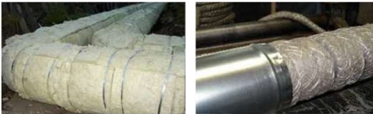
13.2-rasm. Rulo va shnurli issiqlik izolyatsiyasi tuzilmalari.
