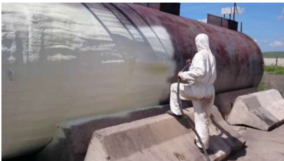
8.10-rasm. Poliuretan ko‘pikli kompozitsiyaning purkash usuli.
