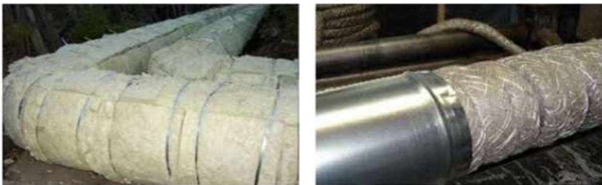
Рисунок 13.2. Рулонные и кордные теплоизоляционные конструкции.
