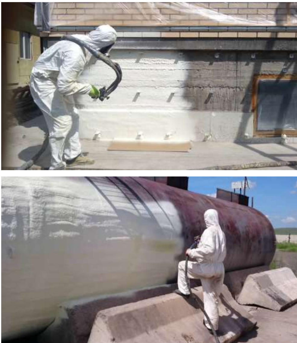
Рисунок 8.10. Метод напыления пенополиуретановой композиции.
