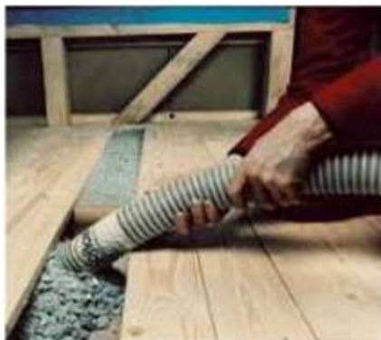
Рисунок 13.7. Литая конструкция теплоизоляции.
