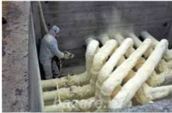
Рисунок 13.4. Конструкции изготовлены методом напыления теплоизоляционных масс.
