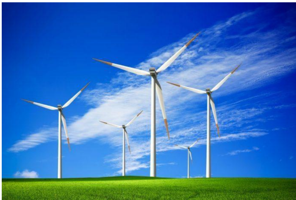
1.2 - rasm. Shamol elektrostansiyasining qir-adirlarda joylashuvi.
