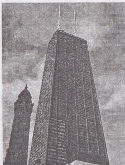
17.8-rasm. Baland bino tashqi bog'lovchi fermalar bilan.
