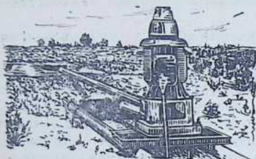
Рис. 83. Скважина вертикального дренажа в совхозе „Пахта-Арал“ (Голодная степь)
