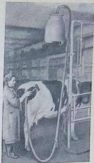
Рис. 91. Установка для чистки коров с помощью вакуума.
