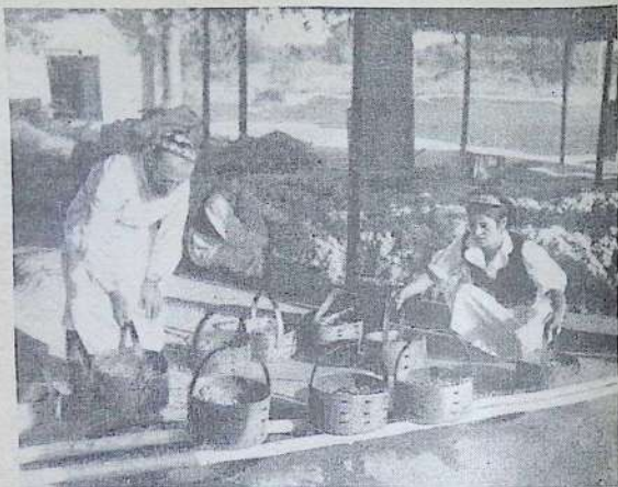
Рис. 135. Обработка винограда в кипящем растворе каустической соды.
