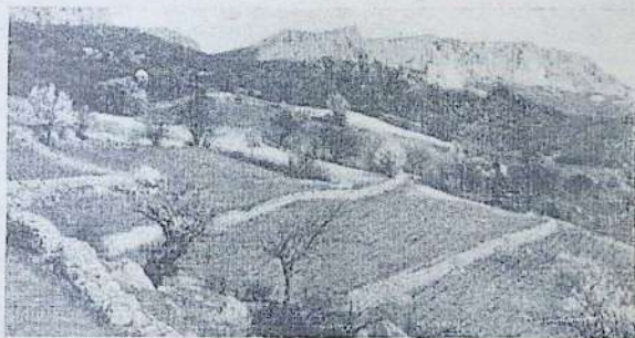
Рис. 35. Подпорные стены на горных виноградниках.
