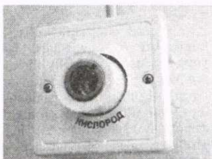
15.5-rasm. Kislorod ulash moslamasi.
