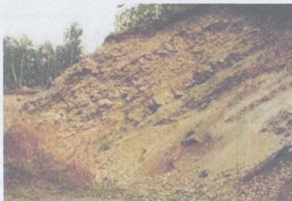
Рис. 3.4. Поверхностный оползень на суглинистом склоне
