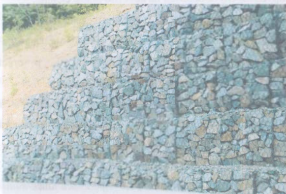
Рис. 3.5. Мероприятия по защите от оползней
