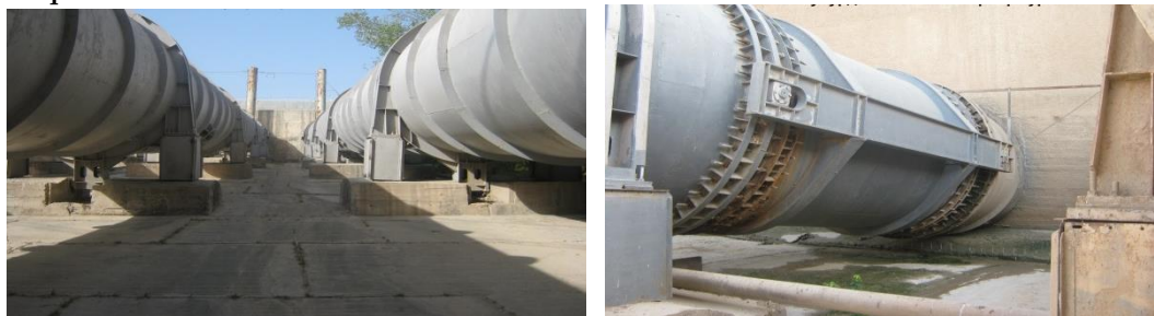
4 - rasm. Bosim quvurlari va kompensatorlar NS KMK diametri 3,60 m.
